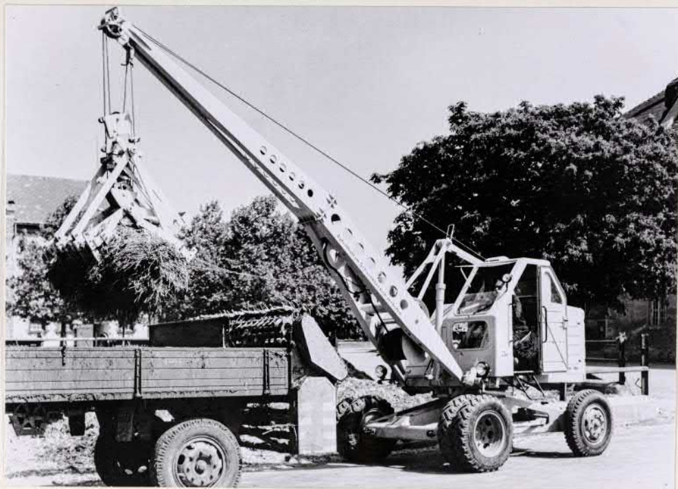
Selbstfahrender Lader T 172 – Weiterentwicklung des T 170
