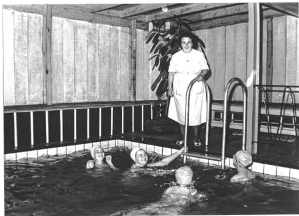
Schwimmbassin in der Sauna des Werkes
