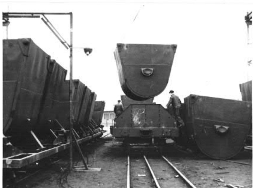
Aufsetzen der Behälter auf Untergestell
