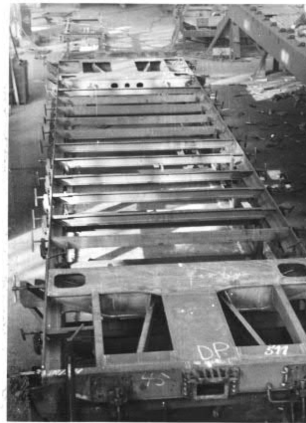
Untergestell Kühlwagen in Schweißvorrichtung
