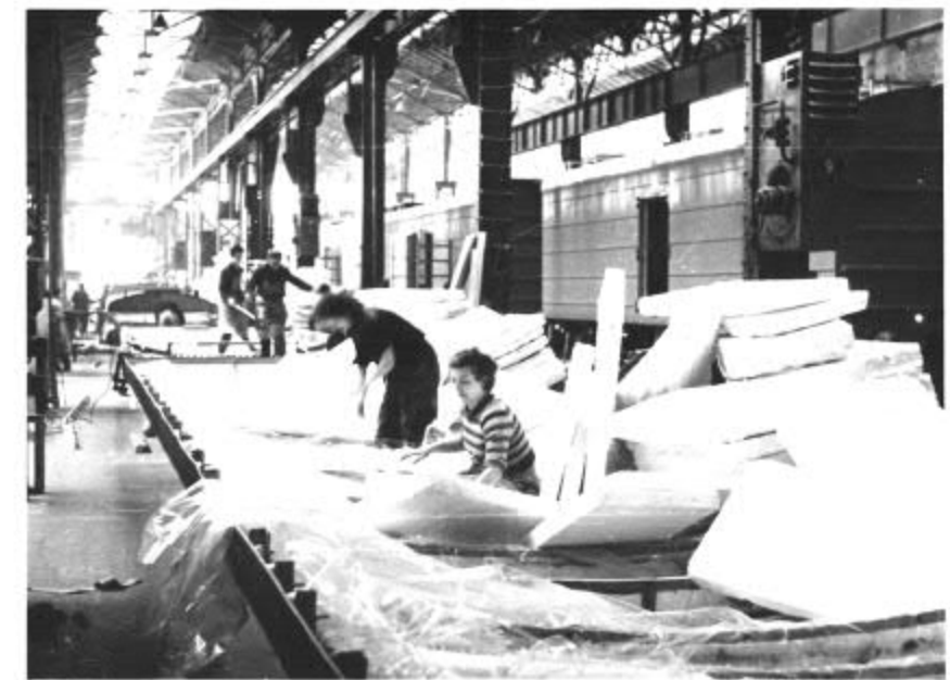
Isolieren des Daches
