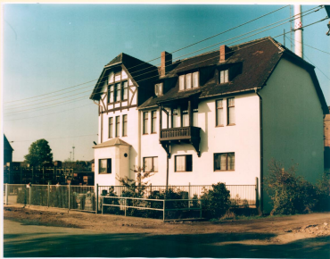
Sozial- und Verwaltungsgebäude der Gläserne Weiner
