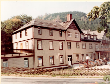
Das in der Unbauphase befindliche Betriebsferienheim in Friedrichroda mit künftig 90 Plätzen
