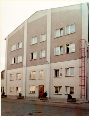
Hauptgebäude der Ersatzteilwirtschaft
