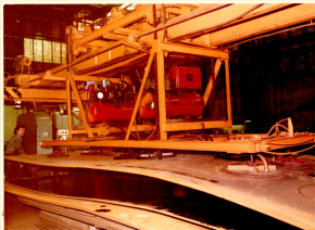
Vakuum-Haftgerät zum Auflegen und Bewegen von Blechtafeln an der 16mm-Schere
