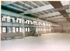
Δ Neue Produktionshalle im Betriebsteil Großheringen, 50x24m ▽ Heizhaus Großheringen in der Bauphase
