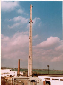
Das Heizwerk mit 8 \times 10 t/h Leistung versorgt den Betrieb und 6500 Wohneinheiten in 3 Neubausandorten mit Wärme und Warmwasser. Die Schornsteinhöhe beträgt 170 Meter. Hauptgebäude des Bereiches Grundfondswirtschaft
