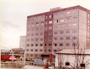
Das in der Bauphase befindliche Haus der Technik beinhaltet künftig Arbeitsräume für Konstrukteure, das Ingenieurbüro und das Büro des Direktors für Technik.
