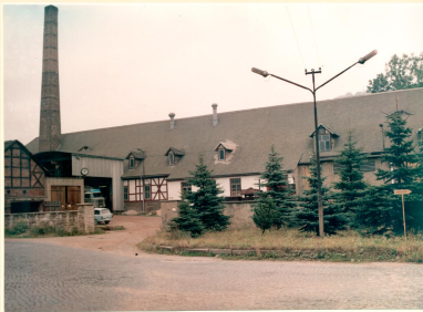
Betriebsteil Bad Sulza, eine ehemalige Saline, heute mechanische Fertigung
