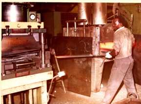
Drücken der Zinken für den Greifer zum Mobilkran
